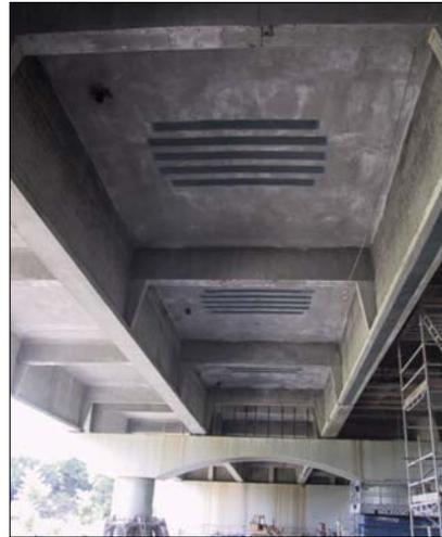
Rinforzo di soletta e travi principali di impalcati da ponte
