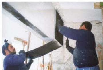
RINFORZO A **TAGLIO** DI TRAVI (fibre disposte secondo la direzione delle staffe)
