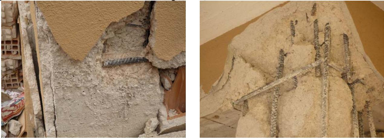
Figura 10. Particolari dei nodi strutturali in un edificio crollato durante il terremoto del L'Aquila..
